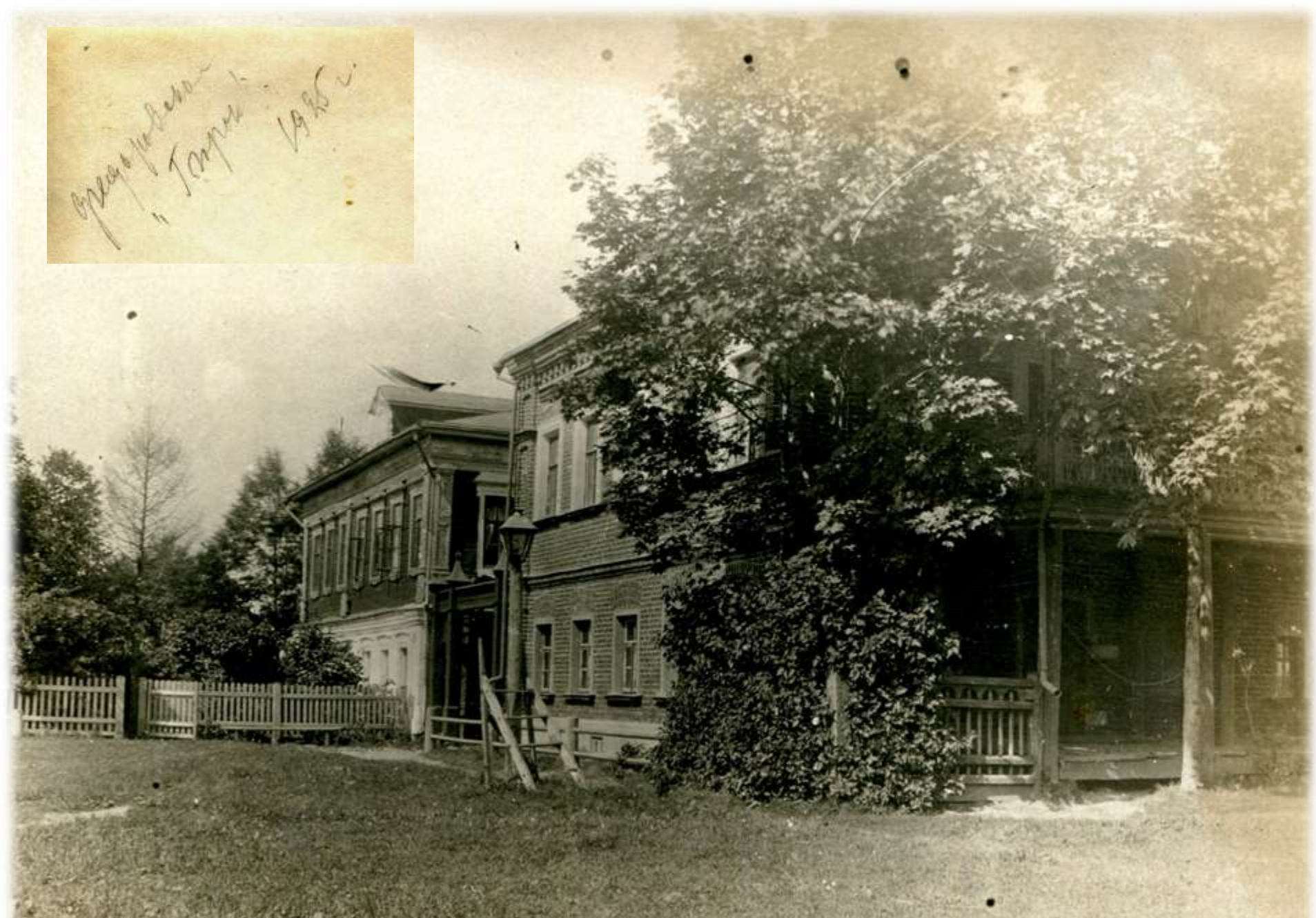
Д. Фёдоровское, предположительно дом и фабрика Пичугиных – 1925 г.
