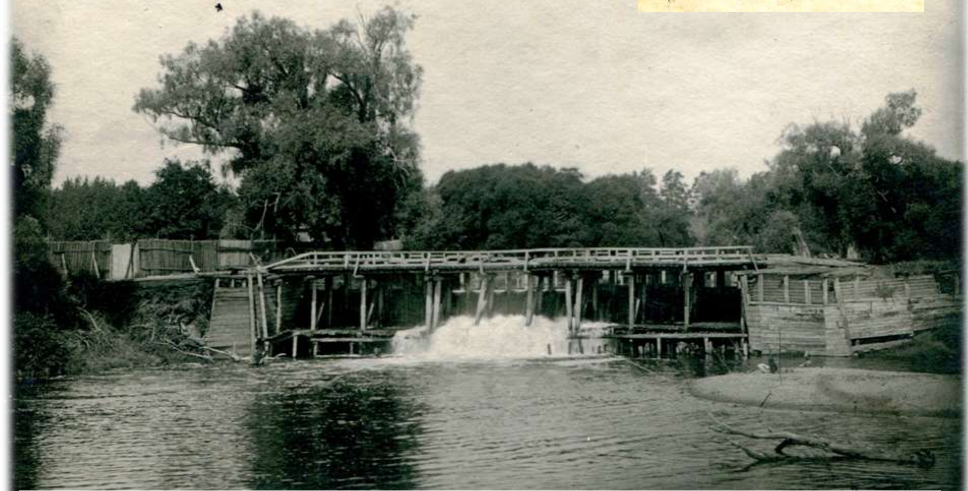
Болховитинская плотина – 1925 г.
